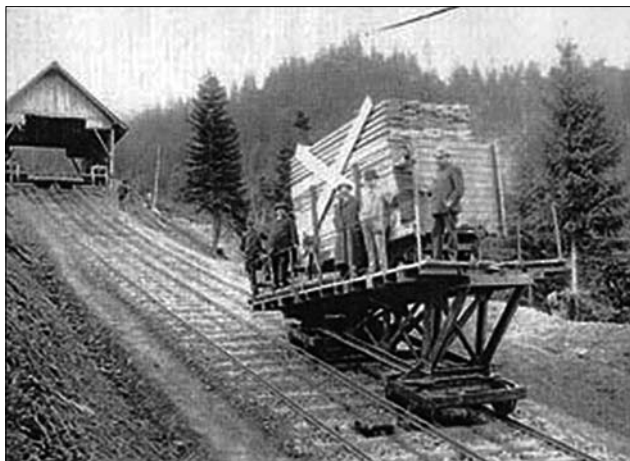
Іл. 10. Винахід інженера Еміля Люкса, с. Командеу, гравітаційний рух платформи по крутопохилій площині. 1898 р.
